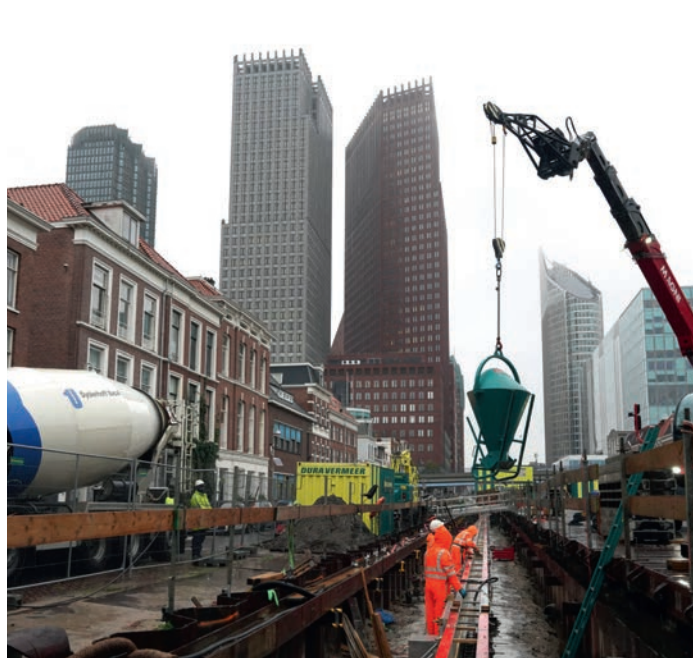
Het storten van het beton voor de kademuur Fotograaf: Jurriaan Brobbel
